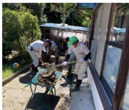
家屋周囲に堆積した土砂の撤去
